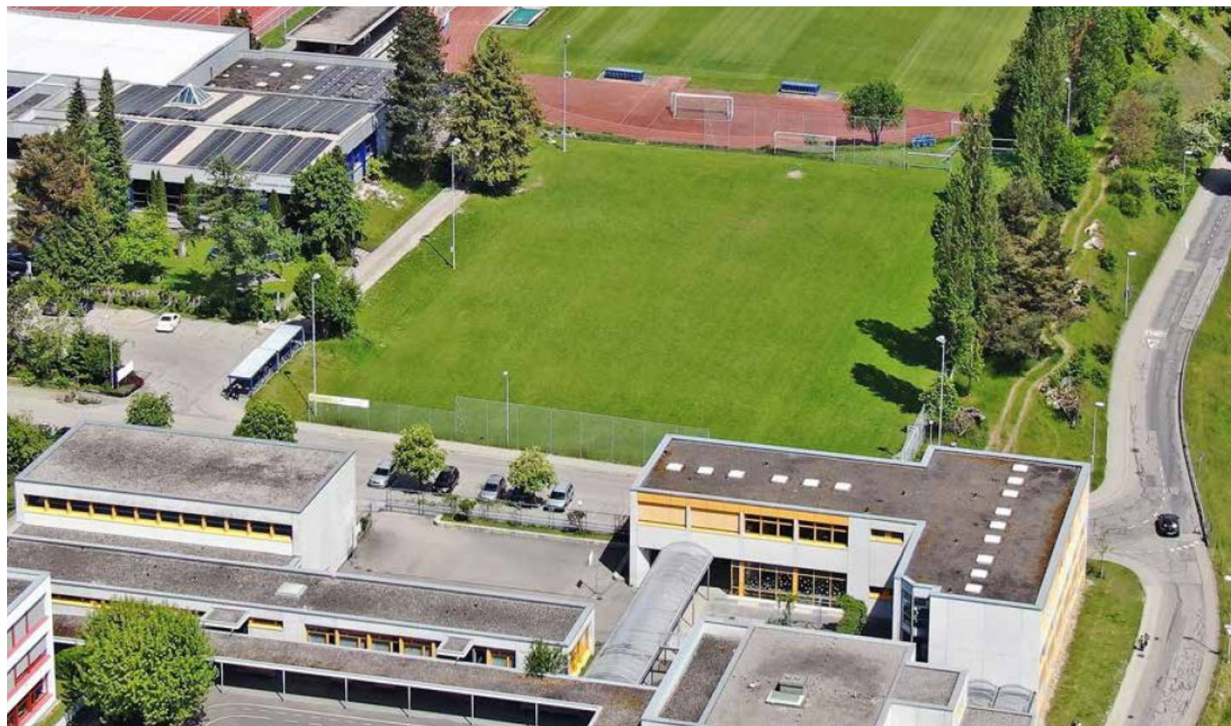
Der Trainingsplatz neben dem Hallenbad wird zu einem Kunstrasenfeld umgebaut. Dieses wird 90 mal 60 Meter gross. Darauf können Spiele bis zur 2. Liga regional ausgetragen werden. Foto zvg/Stadt Willisau
